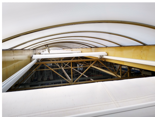
Instalace horizontálních motorových rolet od firmy MORAVIA PROPAG, s.r.o., na třetím místě.
