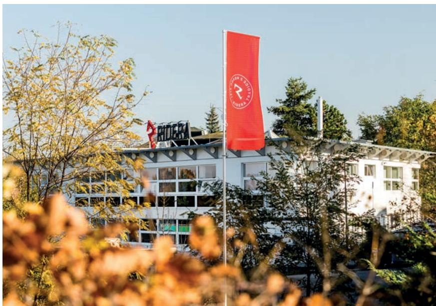
Nová administrativní budova pražské divize společnosti Ridera Stavební v Praze 6 – Ruzyni.
